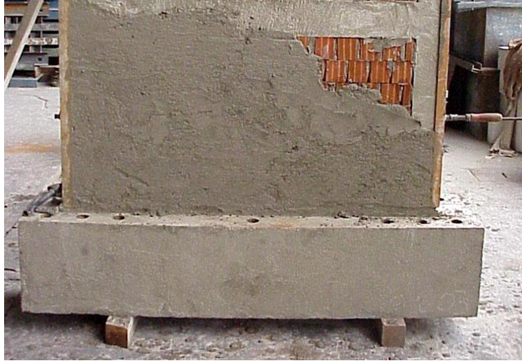
Şekil 3.11. Sıvalı duvar yüzeyi
