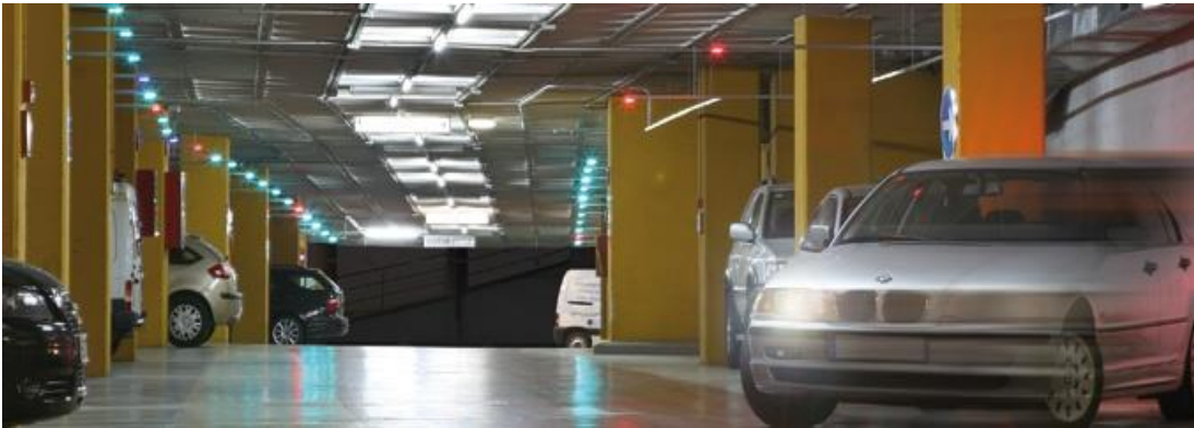
Şekil 6.18. İstanbul'da Kapalı Otopark Doluluk Sensörleri
