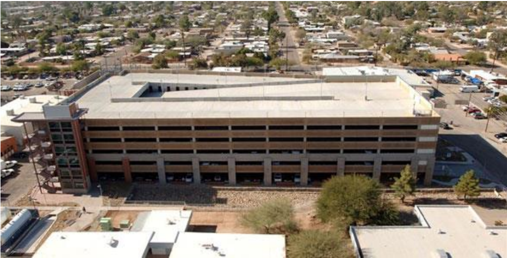
Şekil 9.11. Arizona Northwest Sağlık Merkezi Katlı Otoparkı
