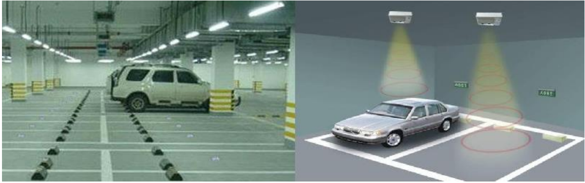
Şekil 6.24. Otopark Doluluk Sensörleri (Anonim, 2015)
