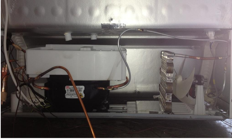
Şekil 4.2. Buzdolabı kabindibinde minikanal uygulaması
