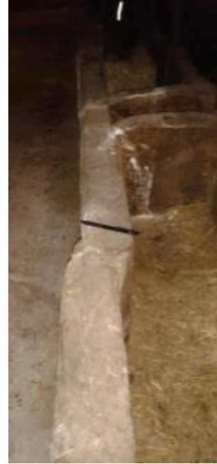
Şekil 6.19.a. Hamamlı Köyü'nde fay zonu üzerinde yer alan ahırın duvarı, b. ahırın içinde bulunan hayvanların yemlerini yediği beton yapıda gözlenen sağ yanal yamulma.
