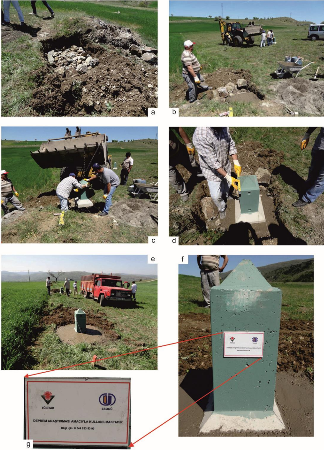
Şekil 7.1. Krip takibi amacıyla fay zonu üzerine yerleştirilen direklerin kurulum aşamaları.
