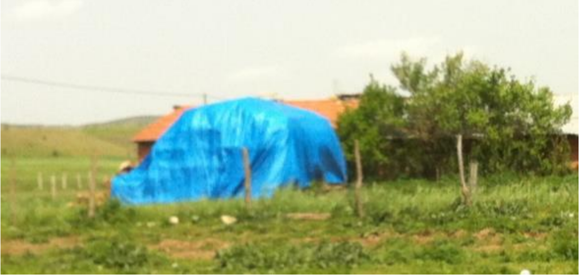
Şekil G.12. Hamamlı'da periyodik ölçüm yapılan ahır duvarı ve ölçümü engelleyen saman balyaları fotoğrafta görülmektedir.
