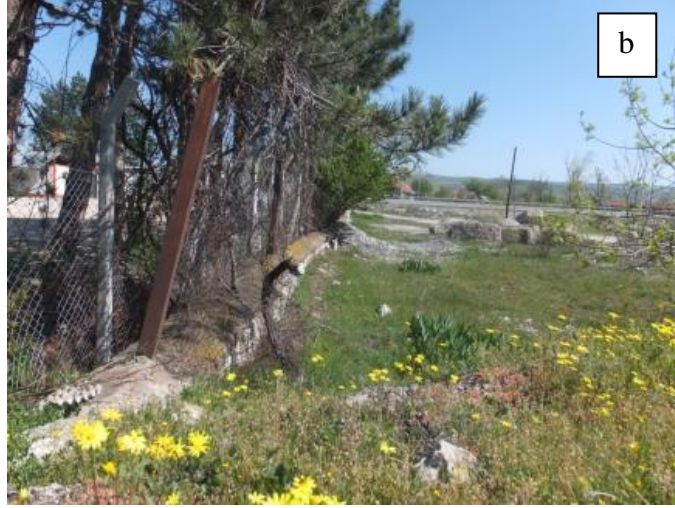
Şekil 6.35. a. İsmetpaşa istasyonu jeolojisi. Fay zonu uzanımı kırmızı çizgi ile gösterilmektedir. b. İsmetpaşa'daki krip hareketine bağlı deformasyona maruz kalan İsmetpaşa Karayolları bakım istasyonu duvarı.
