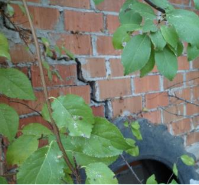
Şekil 6.19.a. Hamamlı Köyü'nde fay zonu üzerinde yer alan ahırın duvarı, b. ahırın içinde bulunan hayvanların yemlerini yediği beton yapıda gözlenen sağ yanal yamulma.
