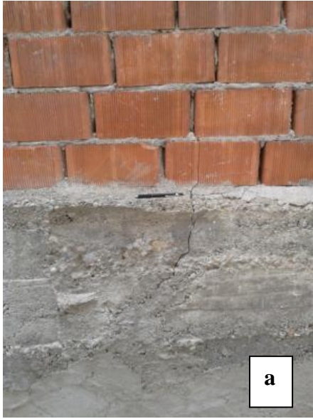
Şekil 6.17.a ve b. İsmetpaşa'da, fay zonu üzerindeki evlerin temel betonlarında ve duvarında görülen çatlak ve deformasyonlar.
