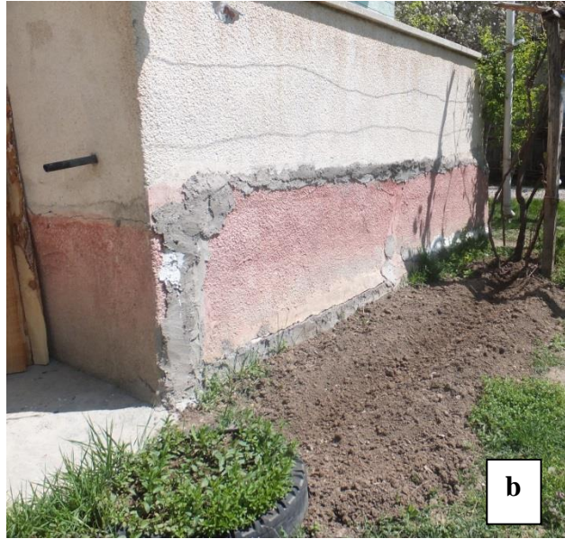
Şekil 6.17.a ve b. İsmetpaşa'da, fay zonu üzerindeki evlerin temel betonlarında ve duvarında görülen çatlak ve deformasyonlar.
