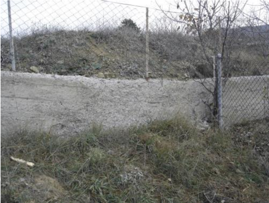
Şekil 6.29. Fatih - Yeni Mahalle'de fay zonu  zerine yapılmıř bir bah e duvarında g zlenen hasar.
