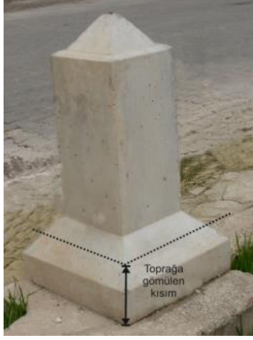
Şekil 2.2. Gzlem istasyonlarının kurulumunda kullanılan dzgn yzeyli beton direkler
