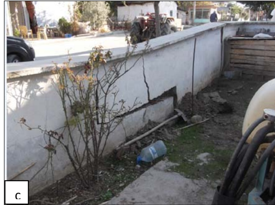
Şekil 6.17. a,b ve c. Yüzey deformasyonu üzerindeki yapılarda gözlenen deformasyonlar (648988 D/4233911 K).
