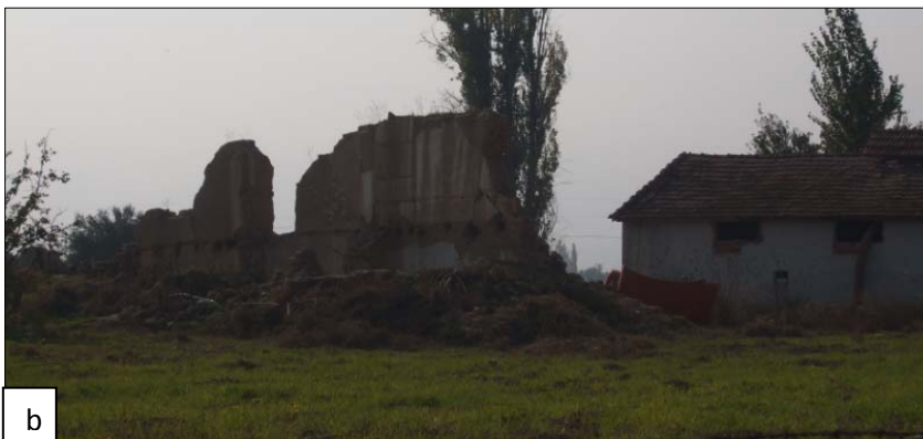
Şekil 6.55 a ve b. Akkeçili Köyünde depremde etkilenen binaların kalıntıları (630895D/4250235K).
