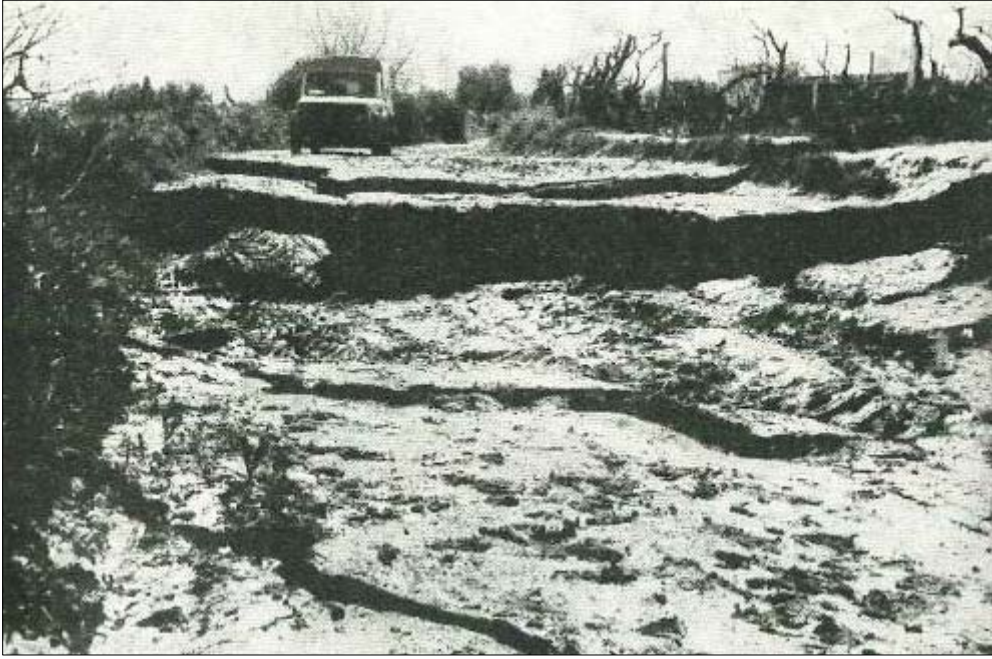
Şekil 5.28. Yüzey deformasyonunun Alaşehir- Akkeçili yolu üzerinde görünen kısmı. Düşey atımın çok fazla olmasının nedeni, zemini meydana getiren malzemenin batıdaki derenin mecrâ dolgusu olmasından dolayıdır. Bakış güneye doğrudur (Arpat ve Bingöl, 1969).
