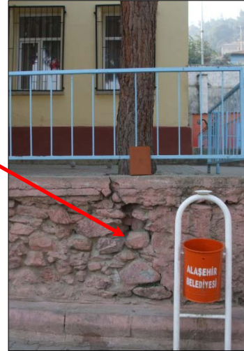
Şekil 6.47. Deformasyon hattı üzerindeki 5 Eylül Okulu bahçesinin zemininde ve duvarda gözlenen deformasyonlar.
