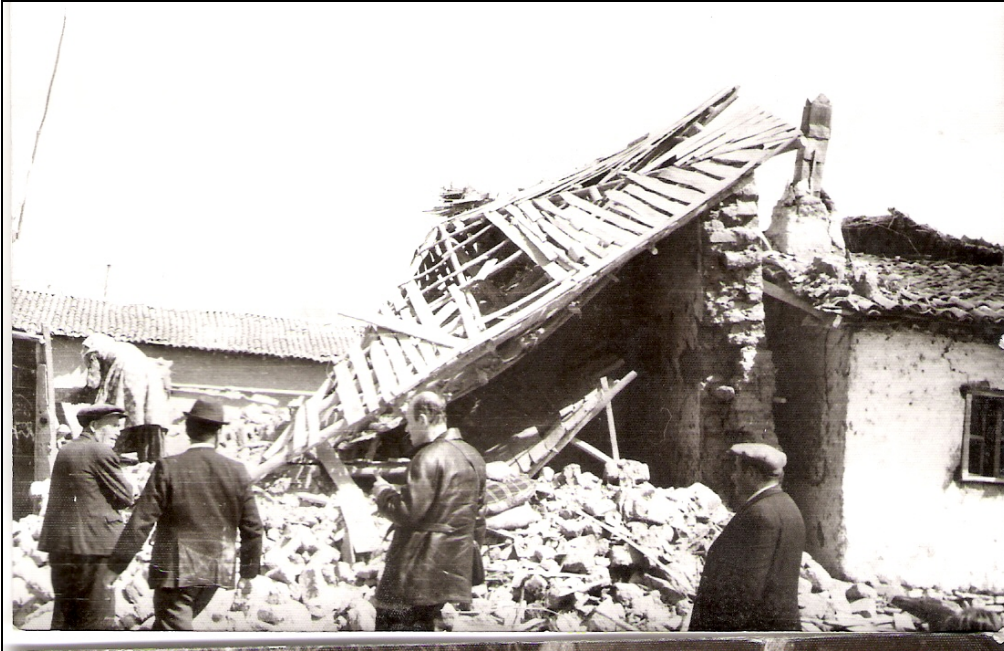
Şekil 5.13. Piyadeler'de kuzey ve batı duvarları KB'ya doğru yıkılan binalardan bir görüntü. (Karamanderesi, 2000).
