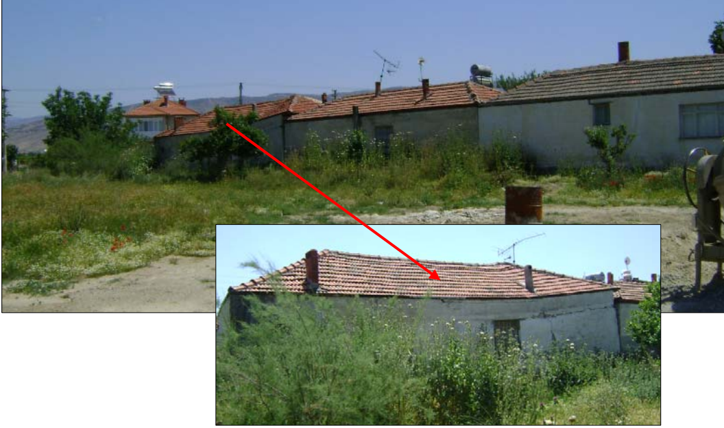
Şekil 6.25. Deformasyona bağlı olarak çatısı yamulan ev (648197 D/4234367 K).
