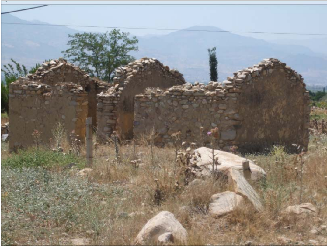
Şekil 6.52. Gümüşçay Köyü'ndeki yıkık evlerden biri (643674D/4248208K).
