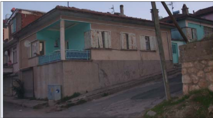
Şekil 6.43. Alaşehir İlçesi içerisinde yüzey deformasyonu üzerindeki evin duvarında gözlenen çatlaklar.
