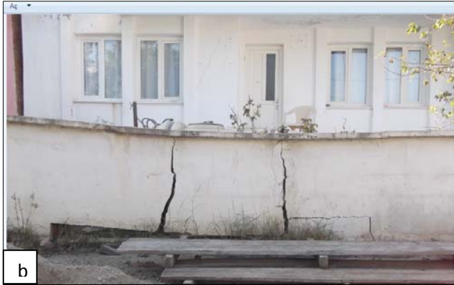
Şekil 6.17. a,b ve c. Yüzey deformasyonu üzerindeki yapılarda gözlenen deformasyonlar (648988 D/4233911 K).
