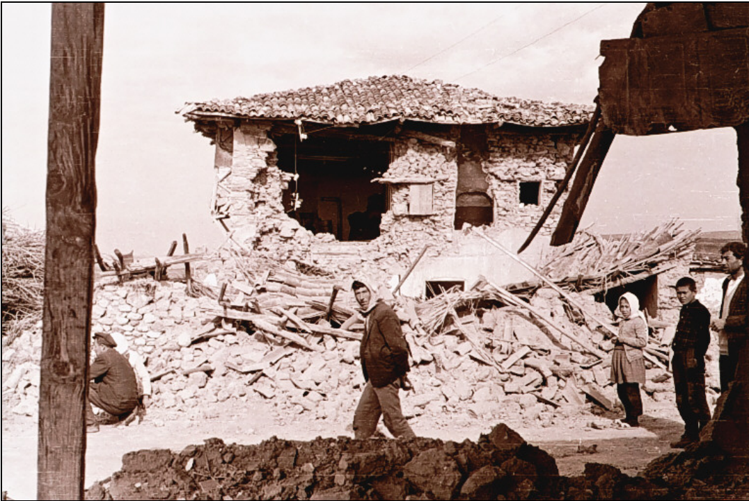
Şekil 5.24. Kemalîye’de (Alaşehir) D-B uzanlı caddede üzerinde D-B uzanlı fay kırılması nedeniyle kuzeyindeki binanın güney duvarı, güneydeki binanın kuzey duvarının yıkılmasının görünümü (Karamanderesi, 2000).
