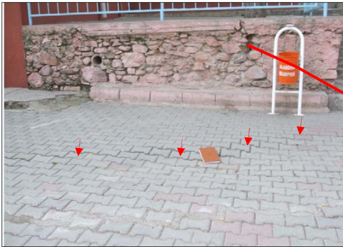
Şekil 6.47. Deformasyon hattı üzerindeki 5 Eylül Okulu bahçesinin zemininde ve duvarda gözlenen deformasyonlar.
