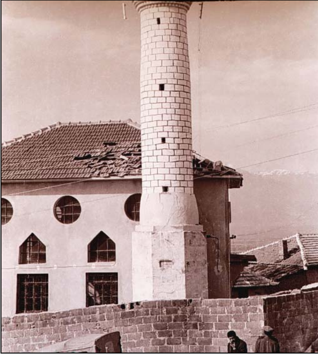
Şekil 5.19. Kemalîye (Alaşehir-Manisa) camisi minaresi batıya doğru yıkılmıştır (Karamanderesi, 2000).
