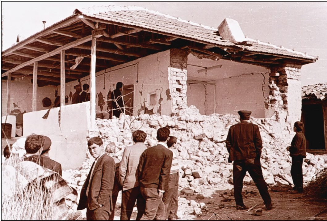
Şekil 5.22. Kemaliye’de eski bir evin güney duvarı güneye doğru yıkılmış. Kuzey güney uzanımlı duvarlarda D-B yönlü çatlaklar oluşmuş (Karamanderesi, 2000).
