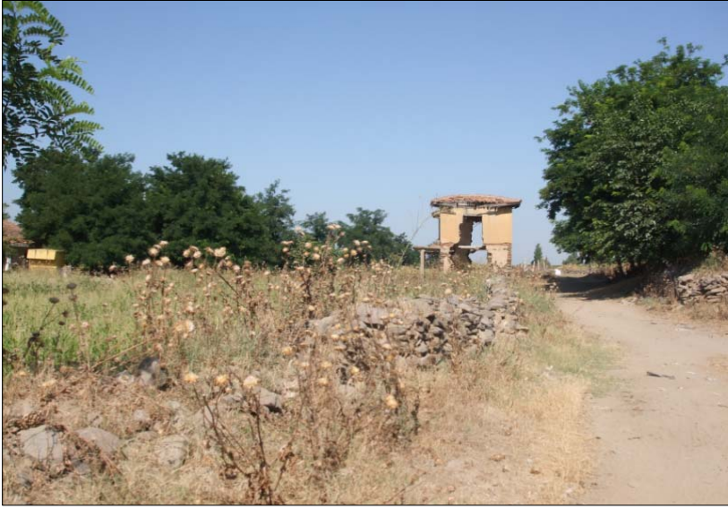
Şekil 6.49. Tepeköy’de depremden etkilenen ve yıkılan evler (635440D/4253194K).
