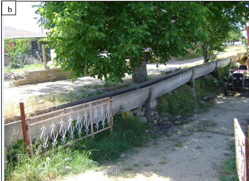
Şekil 6.36. a-b. Ödemiş-Kiraz asfaltında olası kırık üzerindeki DSİ'ye ait yapılar ve sulama kanalı üzerindeki düşey yerdeğiştirme 641897D/4237216K).
