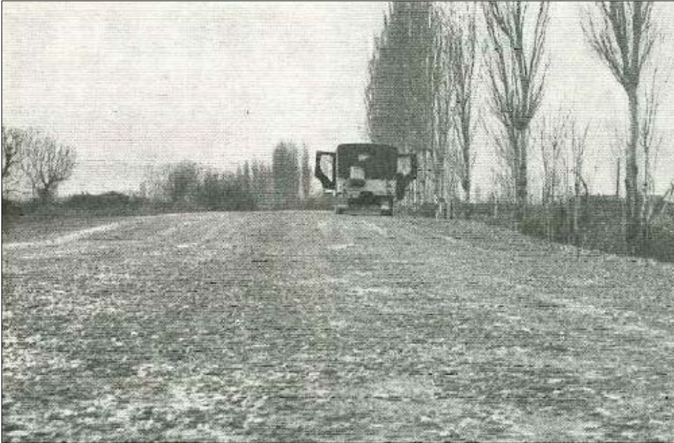
Şekil 5.29. Salihli- Alaşehir yolunda, Alaşehir'in girişine 1300 m uzaklıktaki, deprem sırasında oluşmuş çökme (Arpat ve Bingöl, 1969).
