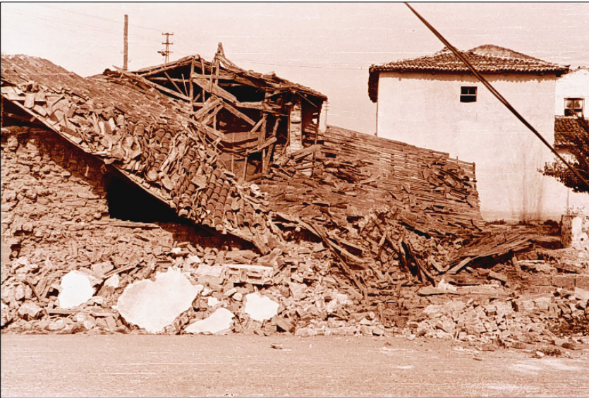
Şekil 5.20. Alaşehir-Tepeköy'de sağlam olmayan zeminde komple yıkılan eski evler (Karamanderesi, 2000).
