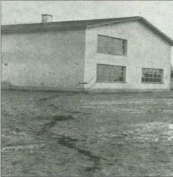
Şekil 5.27. Alaşehir İlçe merkezindeki yüzey deformasyonunun Alaşehir lise binasının doğusundaki görünümü. Kuzey bloğun çöktüğü görülmektedir (Arpat ve Bingöl, 1969).
