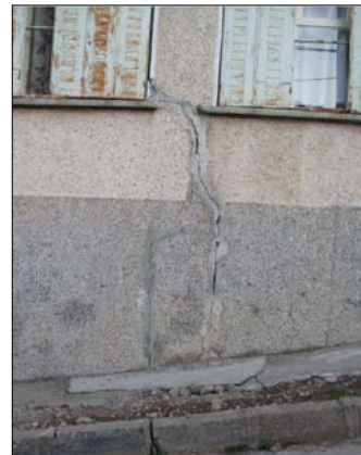
Şekil 6.43. Alaşehir İlçesi içerisinde yüzey deformasyonu üzerindeki evin duvarında gözlenen çatlaklar.
